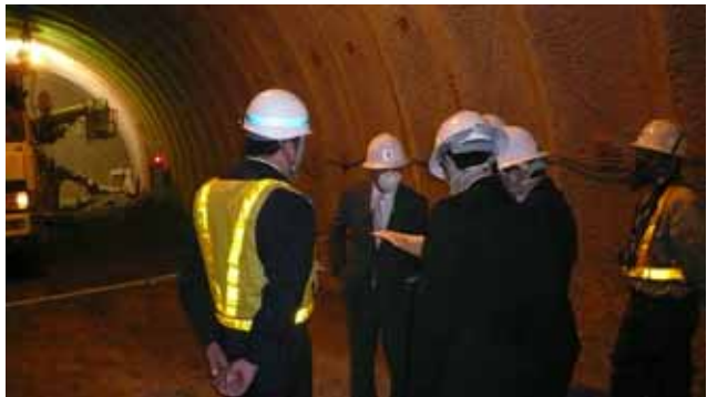
新幹線トンネル採掘現場を視察：北斗市 5月9日
